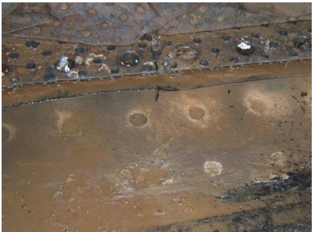
Confinamento impermeabilizzativo – Sua perforazione in corrispondenza del punto di insistenza di uno dei “piedini” di sostentamento.
