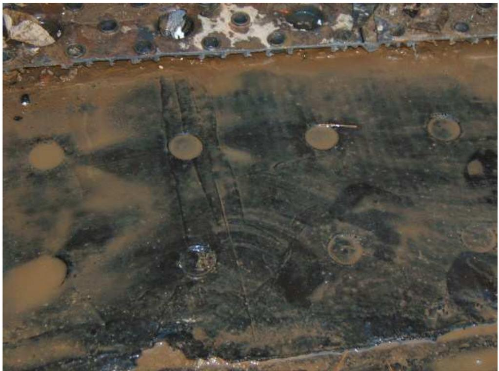
Confinamento impermeabilizzativo – Perforazione della membrana a perdere di protezione e impronte lasciate dai “piedini” sul vero e proprio confinamento impermeabilizzativo.
