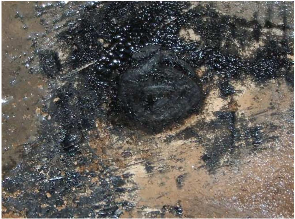
Confinamento Impermeabilizzativi – Impronte lasciate dai “piedini” di un pannello
