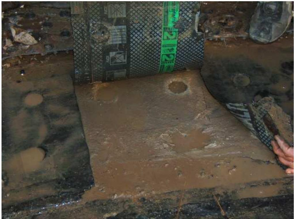
Tipologia del pannello utilizzato e delle impronte lasciate dai suoi “piedini” di sostegno sul confinamento impermeabilizzativo.
