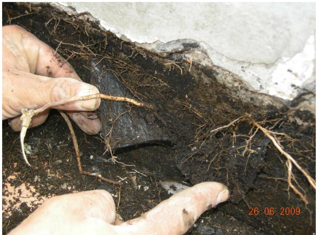
Stato di fatto lungo il parapetto a seguito dello smantellamento delle fioriere lignee poste in accostamento a quest'ultimo – Proliferazione degli apparati radicali a livello del confinamento impermeabilizzativo in corrispondenza del più recente bocchettone di scarico.
