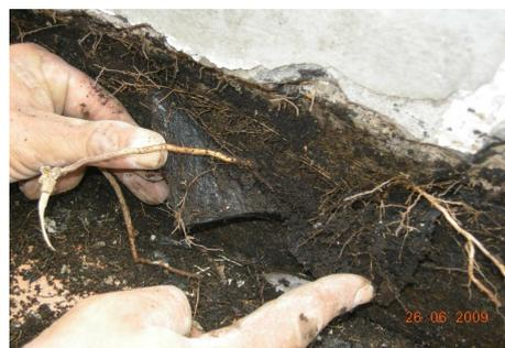
crystallizza, i risvolti verticali del confinamento impermeabilizzativo oltre a disgregarsi, si staccano dalla struttura cementizia su cui erano stati realizzati e a questo punto addio tenuta idrica. Ormai gli apparati radicali sono diventati un'orda incontenibile e pertanto dilagano a livello del confinamento impermeabilizzativo, raggiungono la sede in cui è stato inserito uno dei boc-
