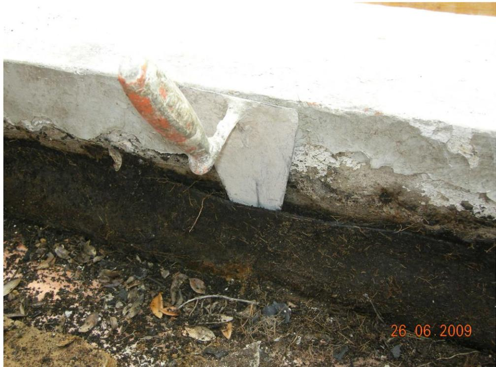
Stato di fatto lungo il parapetto a seguito dello smantellamento delle fioriere lignee poste in accostamento a quest'ultimo – Proliferazione degli apparati radicali a livello sia delle murature sia del confinamento impermeabilizzativo.
