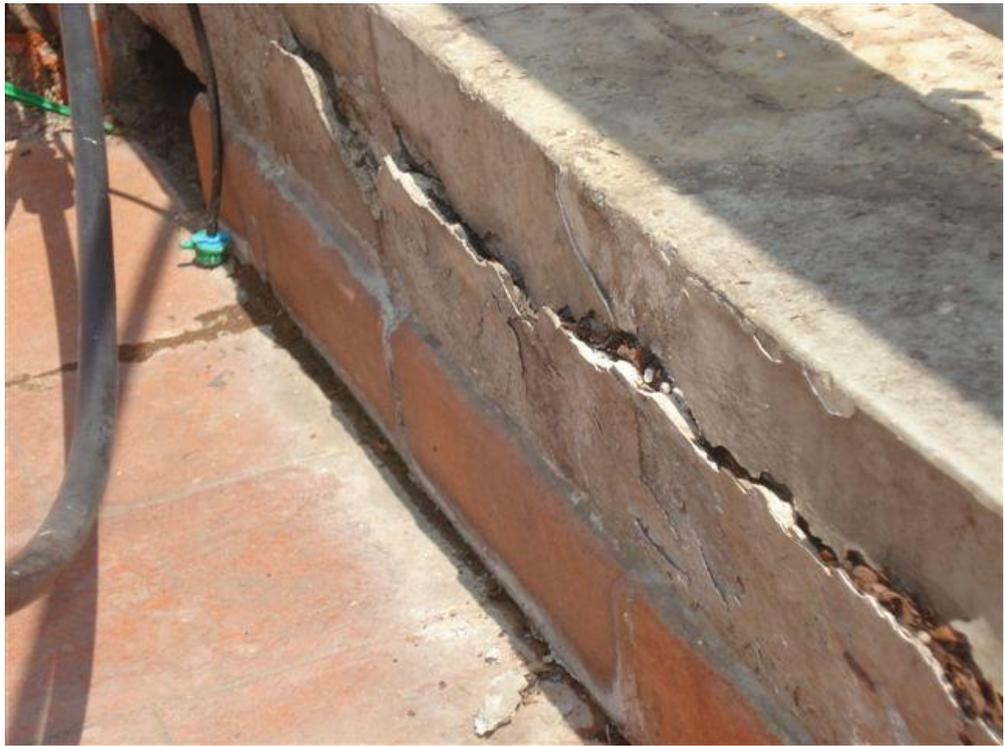
Stato di fatto lungo il parapetto a seguito dello smantellamento delle fioriere lignee poste in accostamento a quest'ultimo – Proliferazione degli apparati radicali a livello delle stratigrafie murarie.
