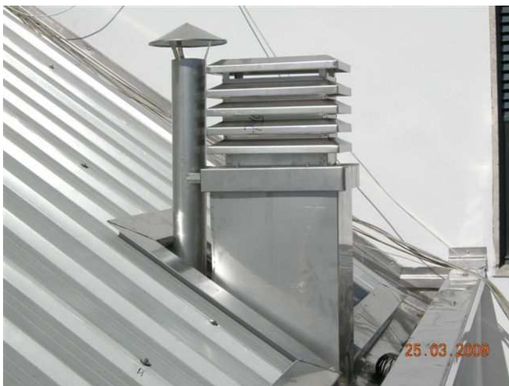
Dettaglio di un camino abbinato ad una colonna di esalazione.
