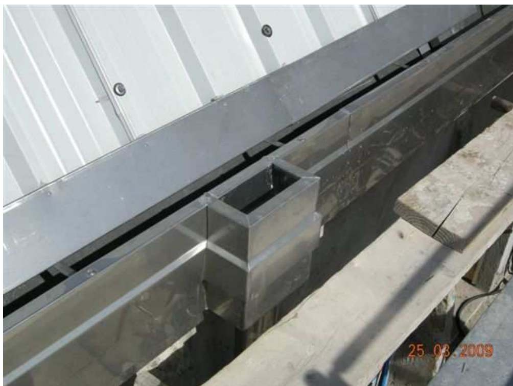
Dettaglio del canale di gronda e del suo sistema di smaltimento.
