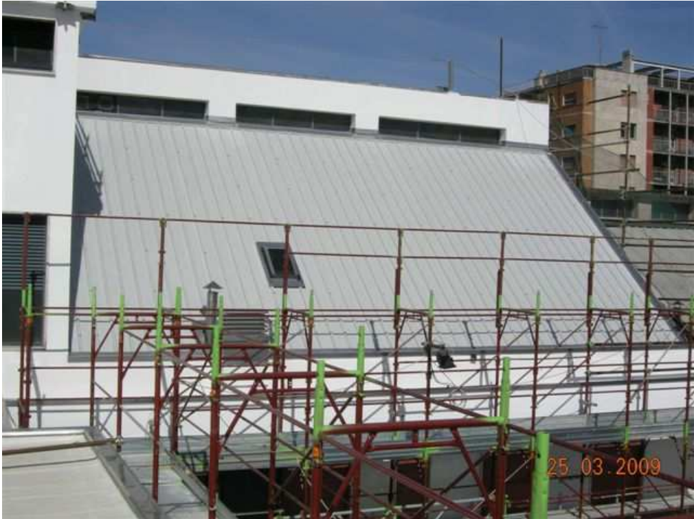
Nuovo manto di copertura.
