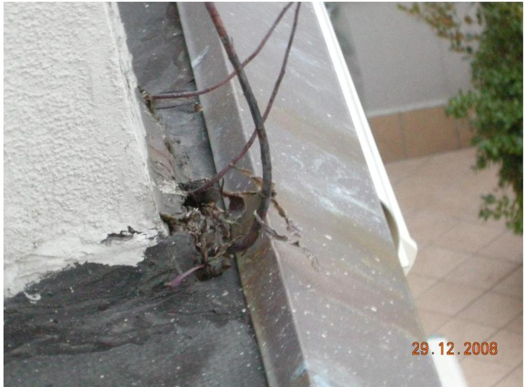
Sviluppo di vegetazione a livello del confinamento impermeabilizzativo
